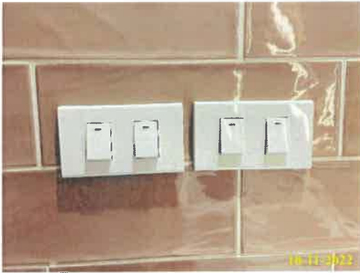
สวิตช์เปิด-ปิดไฟฟ้าสองดวงแบบแยกส่วน
